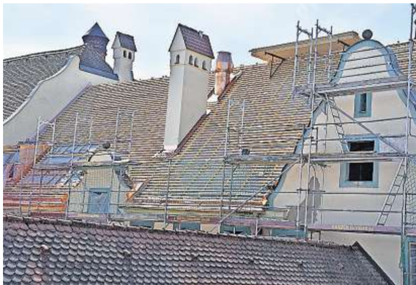
Beim neuen Dach geht es voran. Im Gebäudekern darunter entstehen rund 20 Hotelzimmer.
